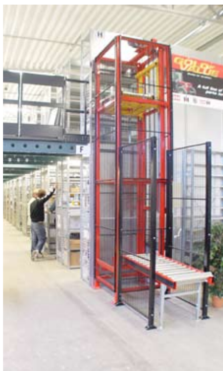
Godsheis mellom etasjene, med transportbånd.
